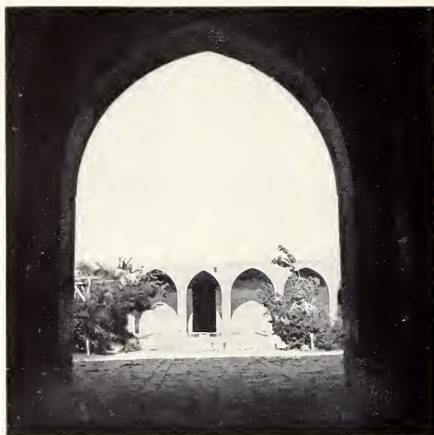
FIG. 31—LA COUR VUE DE L'ENTRÉE
